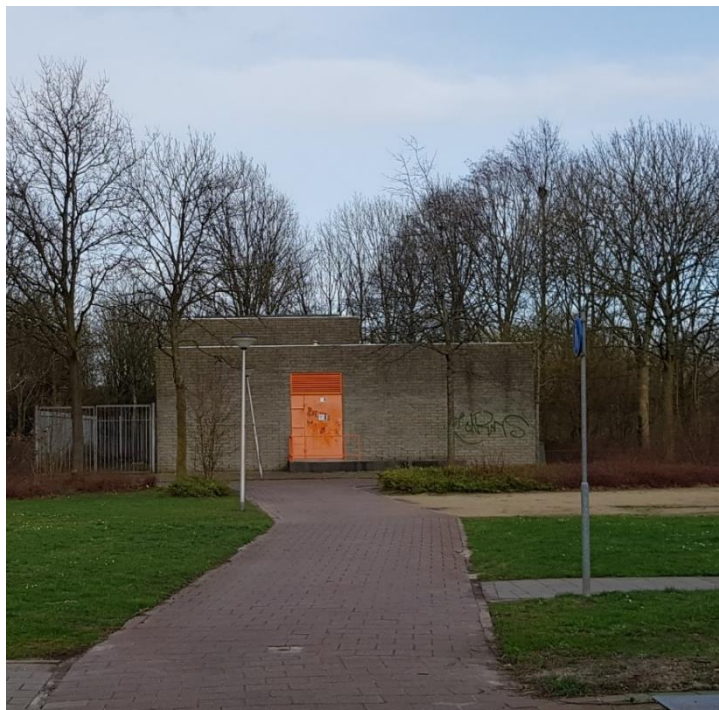
Figuur 19: Rioolgemaal R3
